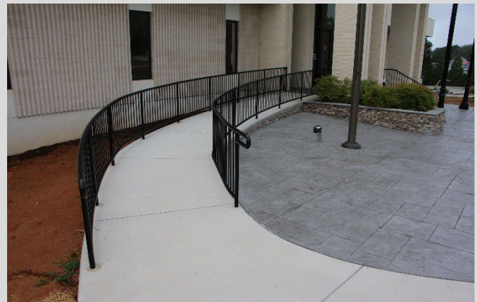
Police HQ ADA ramp
